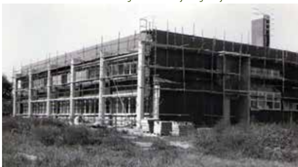
Nova školska zgrada na Krbulji u izgradnji
