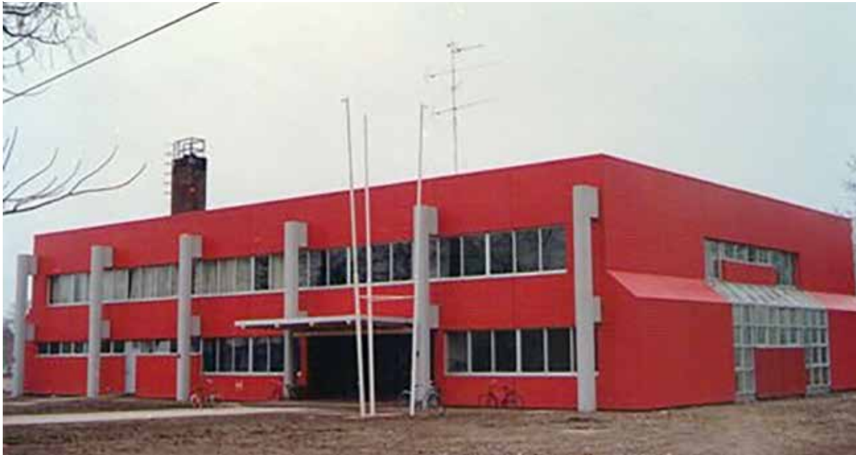
Nova školska zgrada po završetku gradnje 1983. godine
